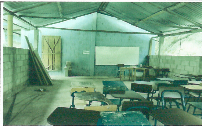
Foto 2: Se prioriza el mejoramiento de piso tipo granito o cerámico, mejoramiento de puertas de metal.
